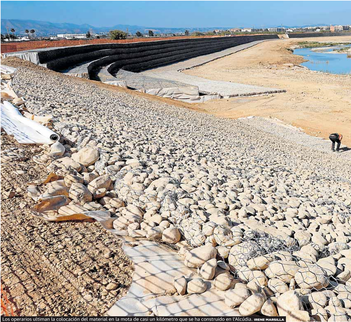
Los operarios ultiman la colocación del material en la mota de casi un kilómetro que se ha construido en l'Alcúdia. IRENE MARSILLA
